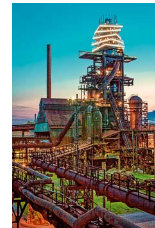
Bolt tower, foto: Tomáš Nekoranec
